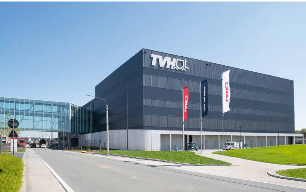
■ Das neue Lager Plant T mit der Verbindungsbrücke für einen effizienten innerbetrieblichen Warenumschlag
