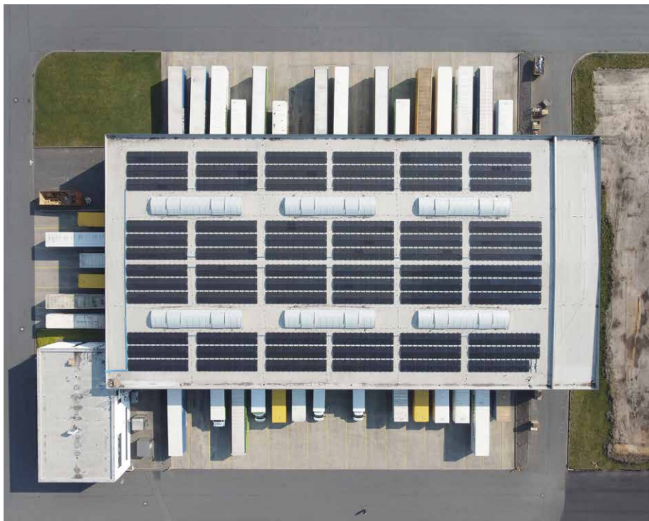
▲ Die Greenflash-Energiesysteme vereinen Photovoltaik, Speicher und Ladeinfrastruktur, hier am Beispiel Boll Logistik.
